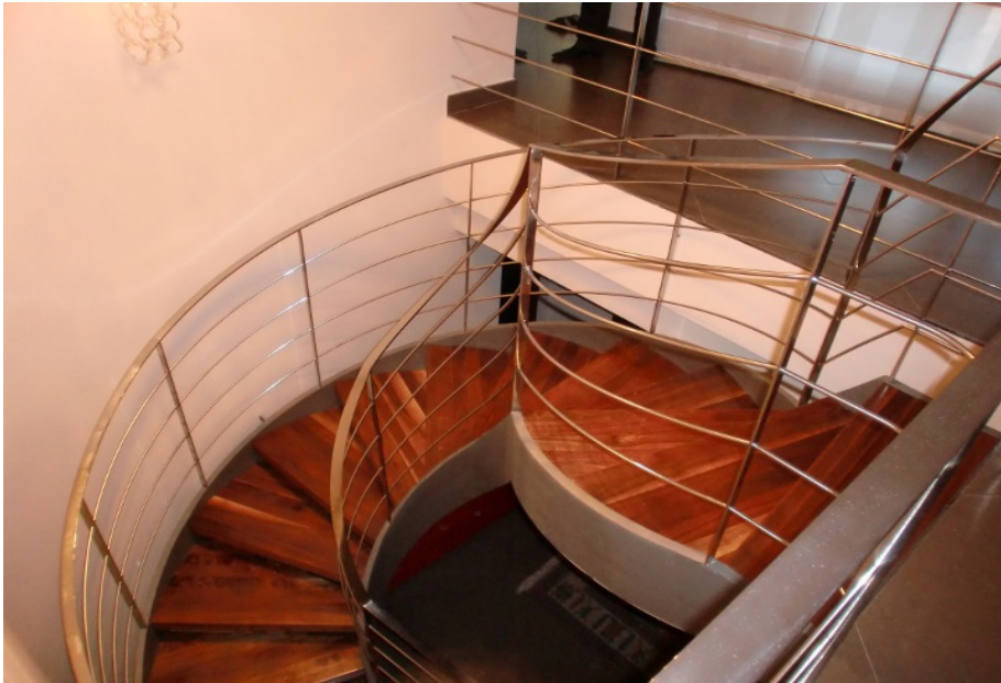
Escalera helicoidal que presenta un contragiro, con zancas de hierro, barandilla de acero inoxidable y peldaños de madera.
