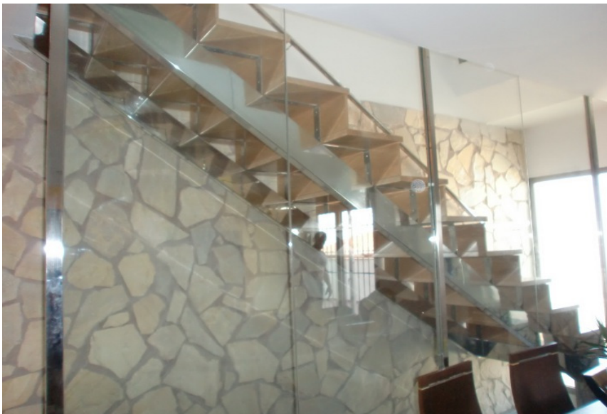
Vista de sendos pasamanos anclados de manera directa a pared.
