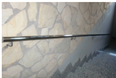
Vista de sendos pasamanos anclados de manera directa a pared.
