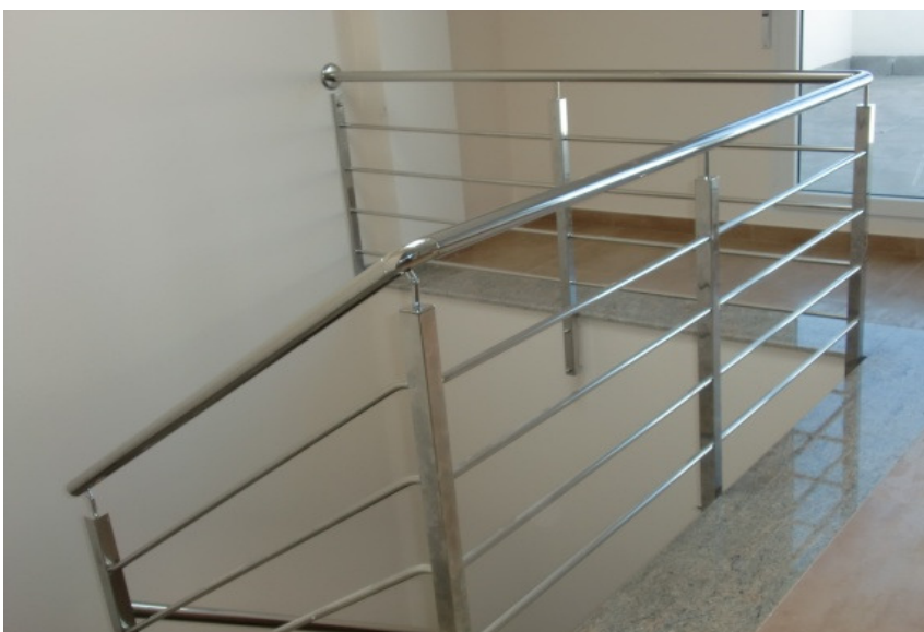
Tramo superior de barandilla de barrote horizontal con pasamano superior y anclajes a forjado.
