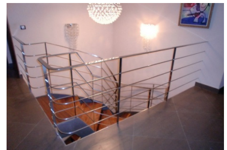
Escalera helicoidal que presenta un contragiro, con zancas de hierro, barandilla de acero inoxidable y peldaños de madera.
