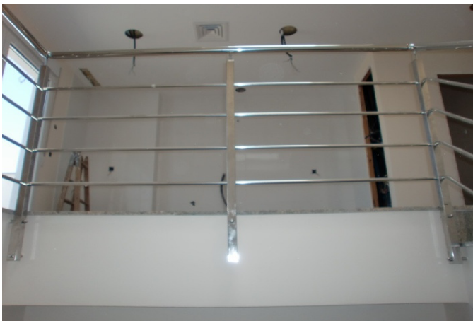
Tramo superior de barandilla de barrote horizontal con pasamano superior y anclajes a forjado.
