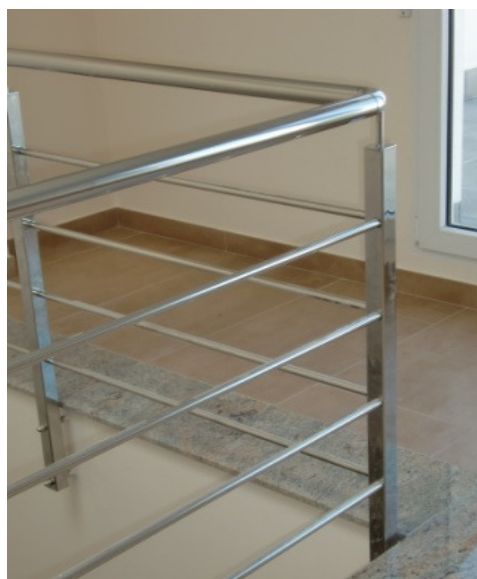
Tramo superior de barandilla de barrote horizontal con pasamano superior y anclajes a forjado.
