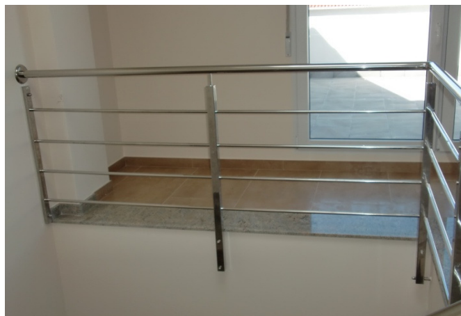
Tramo superior de barandilla de barrote horizontal con pasamano superior y anclajes a forjado.
